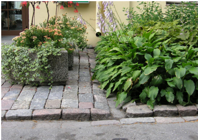
Figur 10. Stuprörsutkastare som avleder dagvatten ytligt.
